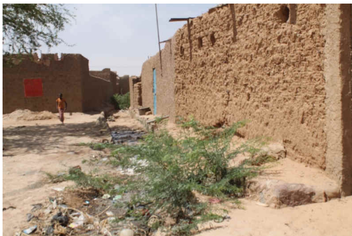
Photo : Rue revêtue en perrés maçonnées
