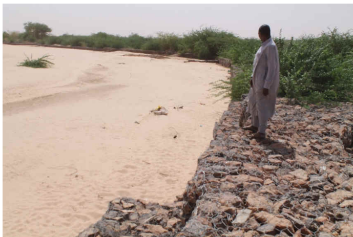
Photo : Digue de Protection des berges en gabion
