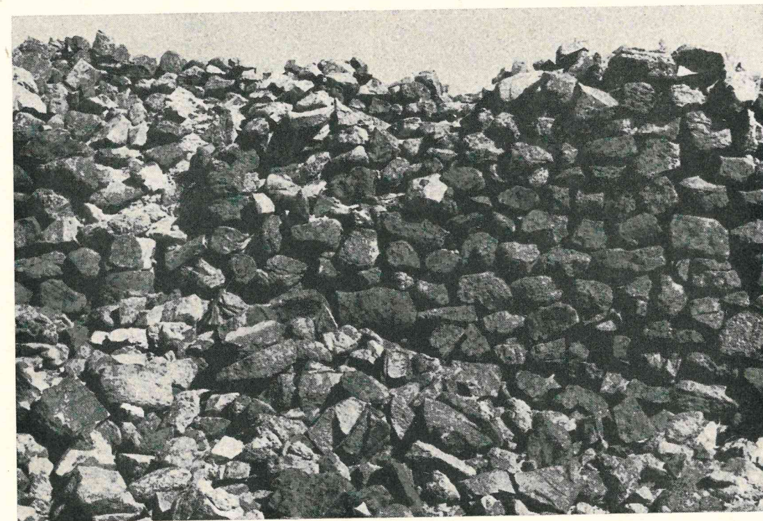
PHOTO 3. — Mur en partie effondré, mais dont on voit parfaitement l'appareillage des pierres qui étaient liées par de l'argile (cliché H. Lhote).
